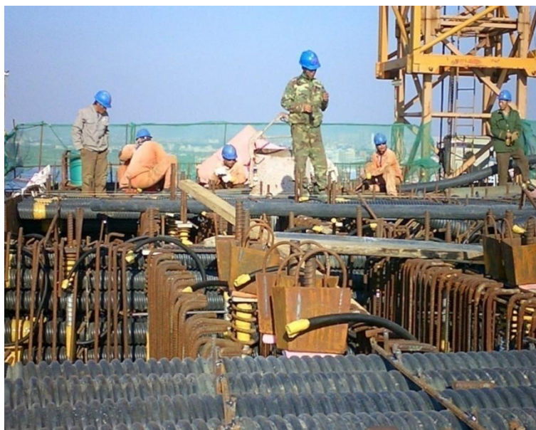
建设中的广深沿江大桥
